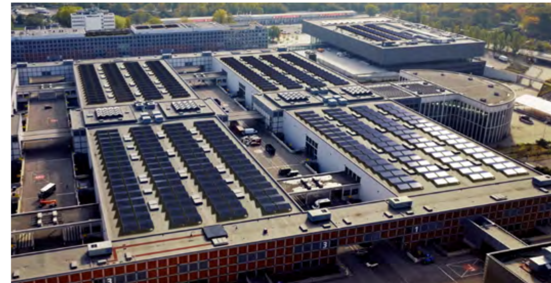
Vision Photovoltaik-Projekt Messedächer 2023-2025, Quelle Messe Berlin GmbH
